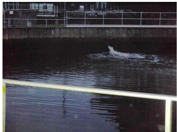
5 gros plan d'arrivée d'eau du bassin de décantation
