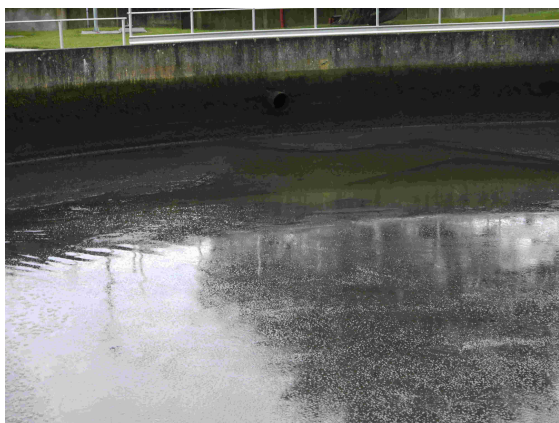
6 fond du bassin de marée plein de boues
