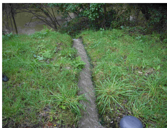
9 écoulement du trop plein de Lescoat vers le ruisseau de Kerloch
