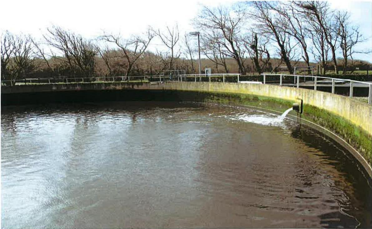
Bassin à marée — rejet des eaux traitées ; traces d'effluents bruts sur la paroi du bassin
