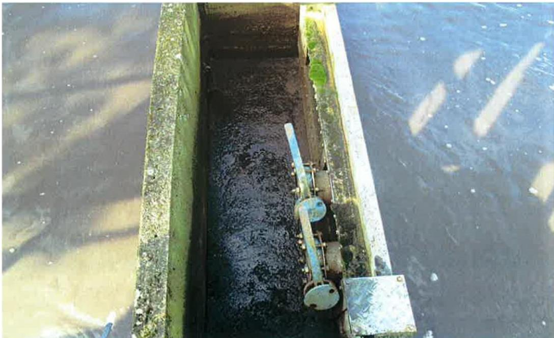
Bassin d'aération - Vannes de by-pass ; trace de passage au by-pass dans canal
