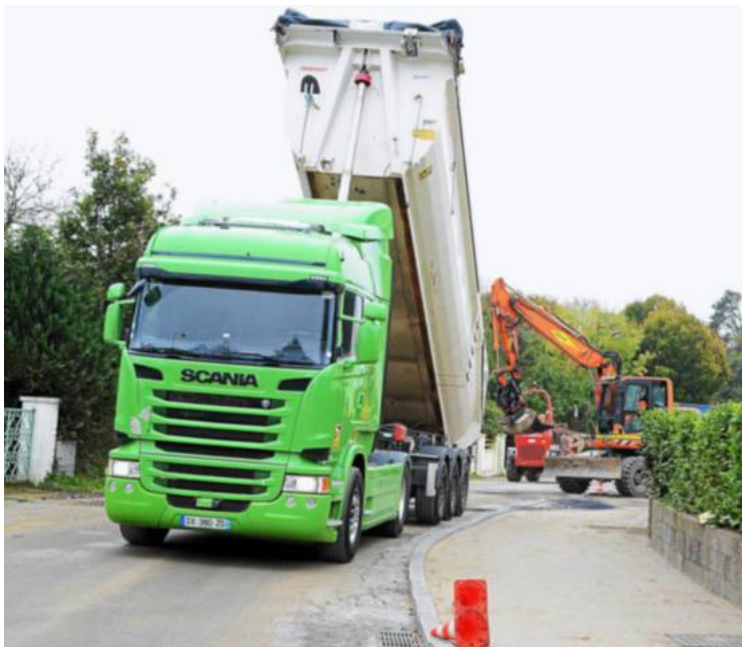
L'enrobage des trottoirs et du parking de l'école a débuté.
